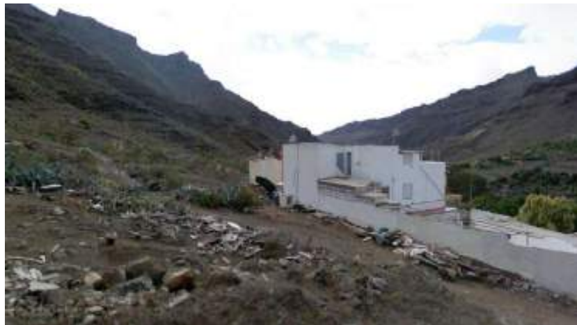
Edificaciones existentes en el contacto del ámbito afectado por la MM con el Suelo Urbano Consolidado. Impacto paisajístico producido por las medianeras vistas.
