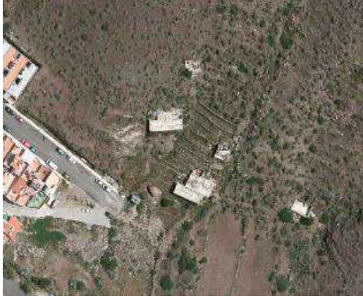
Edificaciones en ruinas.
